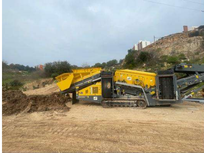
תמונה 23 מגרסה בכביש דורי, חיפה
